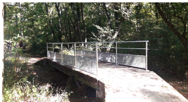
Nouveau garde corps de la passerelle du parcours de santé
